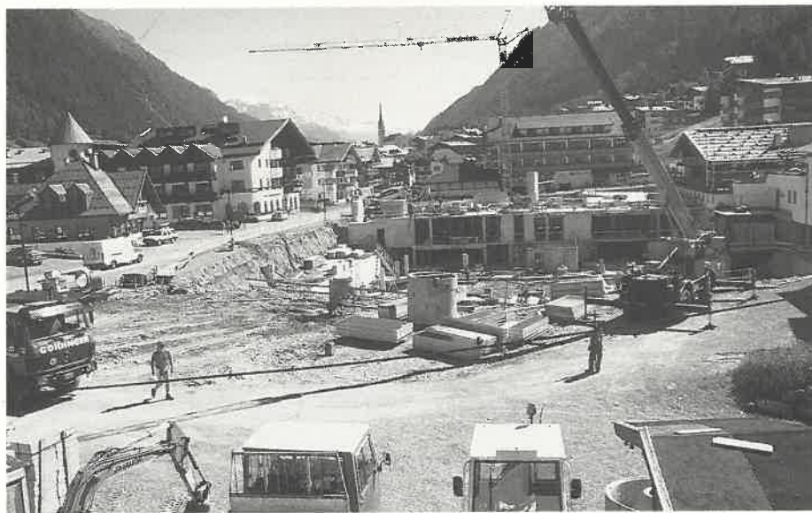
Großbaustelle Hotel Trofana Royal Baumeister Josef Zangerle
