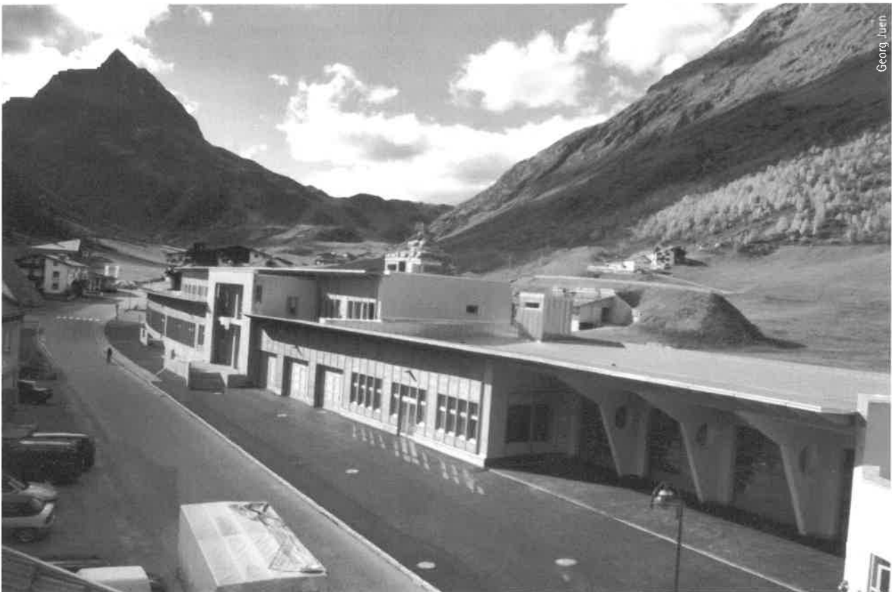
Alpinarium mit Zivilschutzzentrum und Tiefgarage
